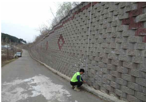
c. 측정분할 전경
